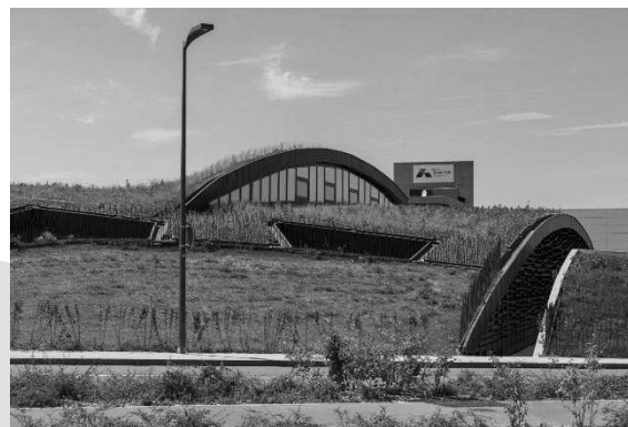
Exemple d'une toiture végétalisée – Restaurant Universitaire le Metz'In à Metz Technopôle (source : www.archiliste.fr )
