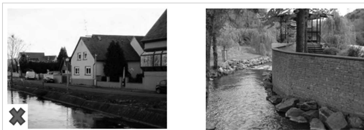
Figure 3 : Exemple de berges fortement aménagées et imperméabilisées avec de nombreux enrochements, source : PLU de Strasbourg
