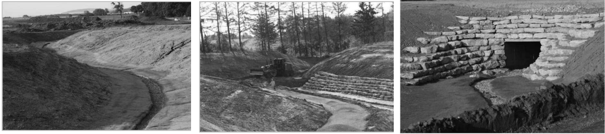
Figure 5 : Exemple de la renaturation du ruisseau de la Ramotte au niveau du Plateau de Frescaty à Augny. Anciennement busé sur environ 600m, la Ramotte est aujourd'hui remise à ciel ouvert et intégrée dans le parc de 4 ha dans le cadre de l'aménagement de la ZAC
