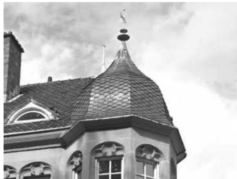
Comble à l'impériale (avenue Foch à Metz)
