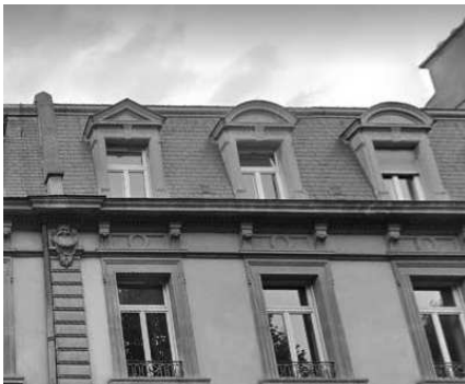
Comble à la Mansart (avenue Foch à Metz)
