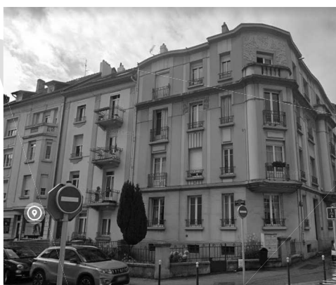
Exemples de façades
